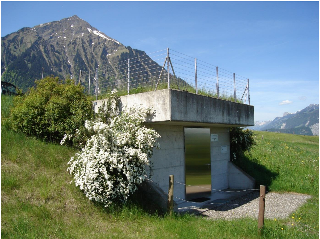
Kleinreservoir/Kleinkraftwerk Lengmattli, Aeschi (Erstellt 1999)
