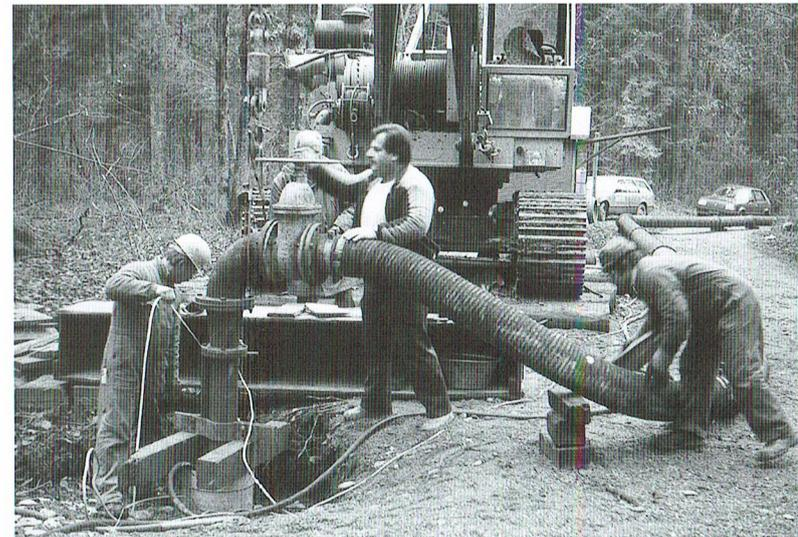
Probebohrung mit Pumpversuch für den provisorischen Grundwasserbrunnen im Unteren Kandergrien. Dezember 1987.
